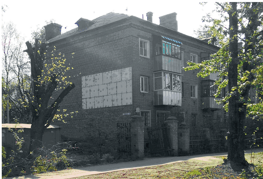
Рис. 2. Наружное утепление отдельной квартиры в многоквартирном доме
